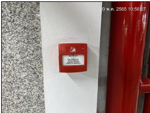
ภาพที่ 16(ต่อ) กริ่งสัญญาณเตือนภัย
